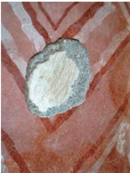
*Éclat d'un enduit chaulé sur une colonne du chœur. Cet accident révèle la texture du support de pierre et des enduits chaulés ainsi que les repeints.*
